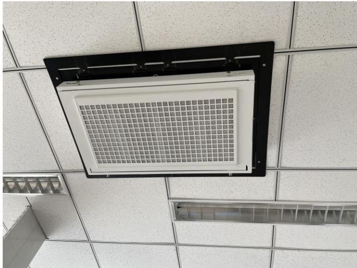
图 4-7 中药实验室排风口废气处理装置
