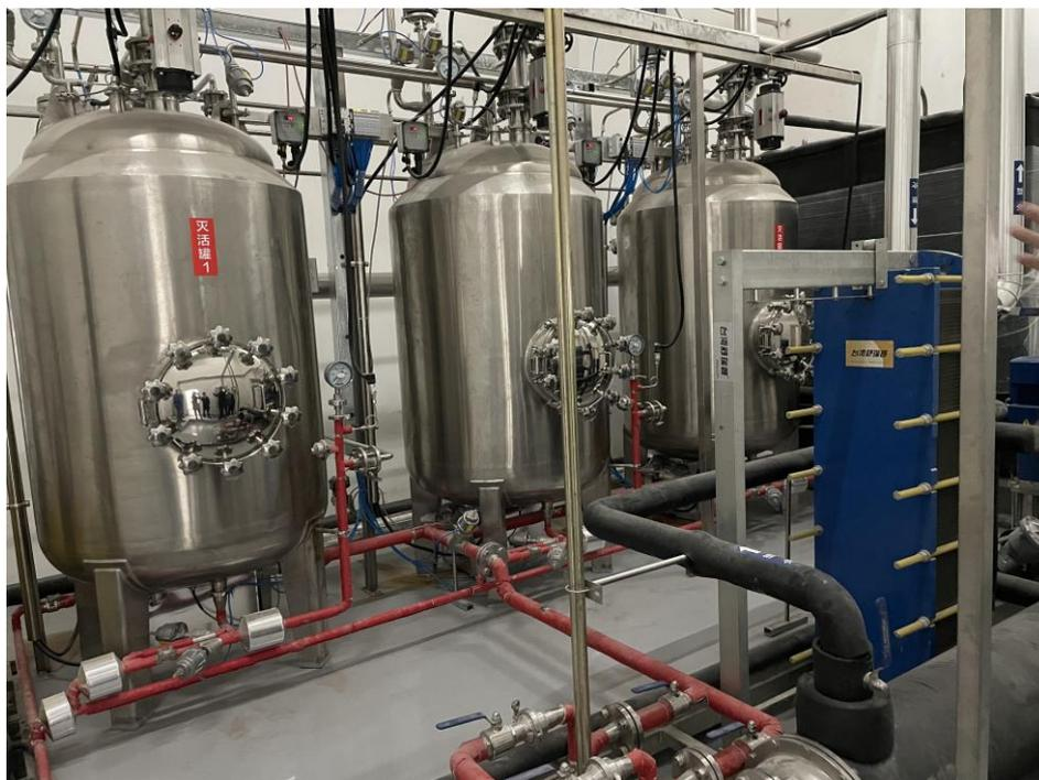
图4-1 生物安全三级实验室灭活罐照片
